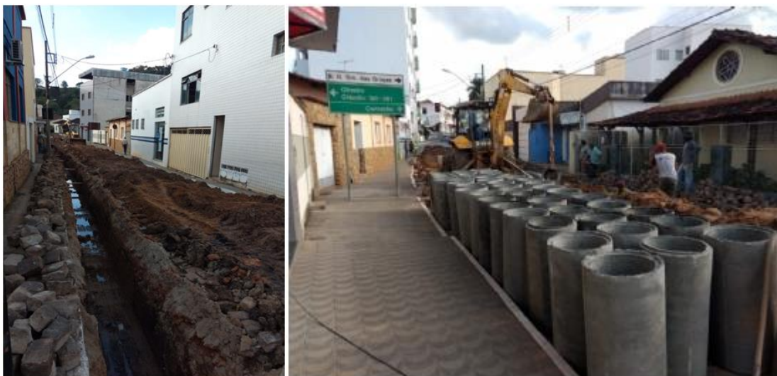
Figura 140 - Obra de drenagem para escoamento pluvial na Rua Cônego Cesário
