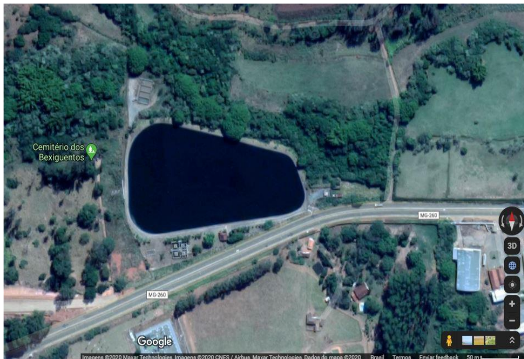
Figura 97 - Estação de tratamento de esgoto
