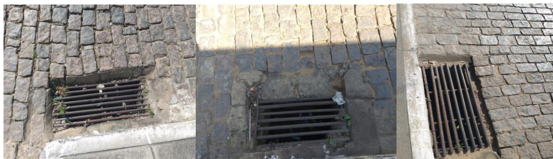
Figura 138 - Bocas de lobo
