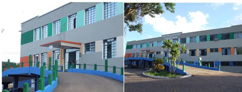
Figura 22 - Hospital Santa Casa de Misericórdia e Maternidade
