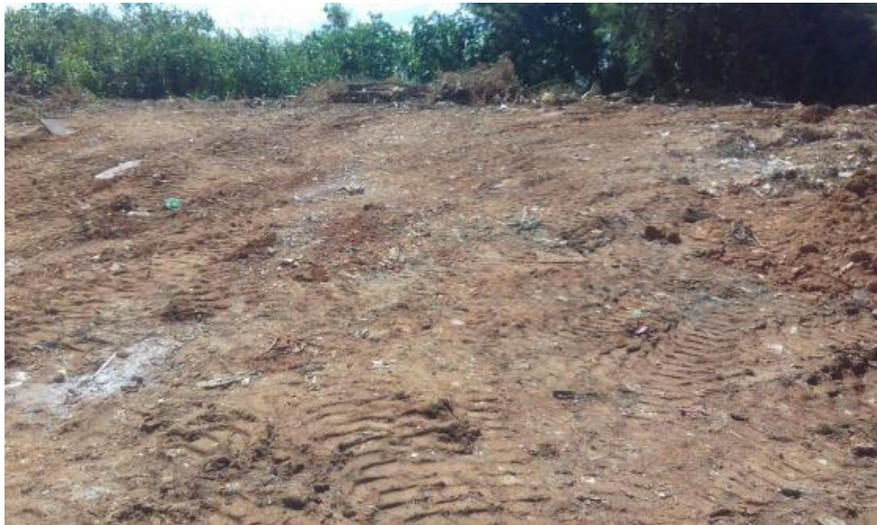
Figura 167 - Recobrimento dos resíduos sólidos no Aterro Controlado de Itapecerica
