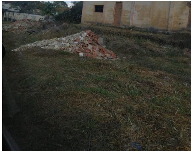
Figura 194 - Bota fora de RCC
